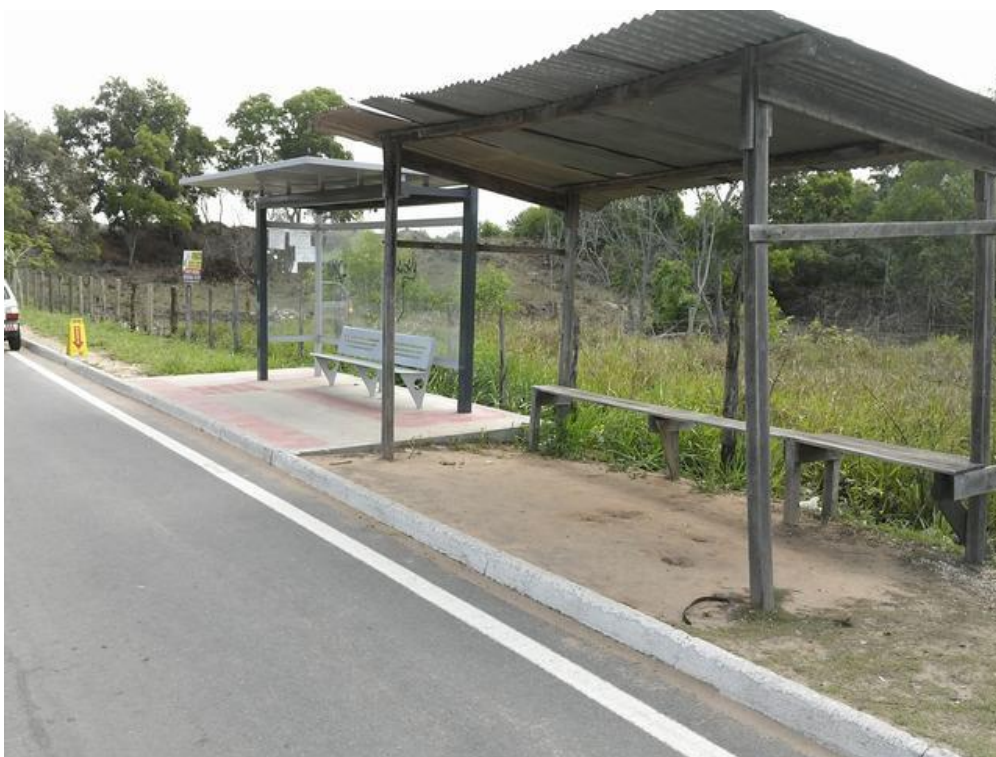
imagem 1 – exemplo de abrigo improvisado ao lado de abrigo metálico
