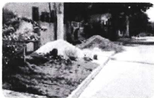
Incorreta. Neste tipo de obra é necessário providenciar passagem provisória dos pedestres pelo leito carroçável da via.
