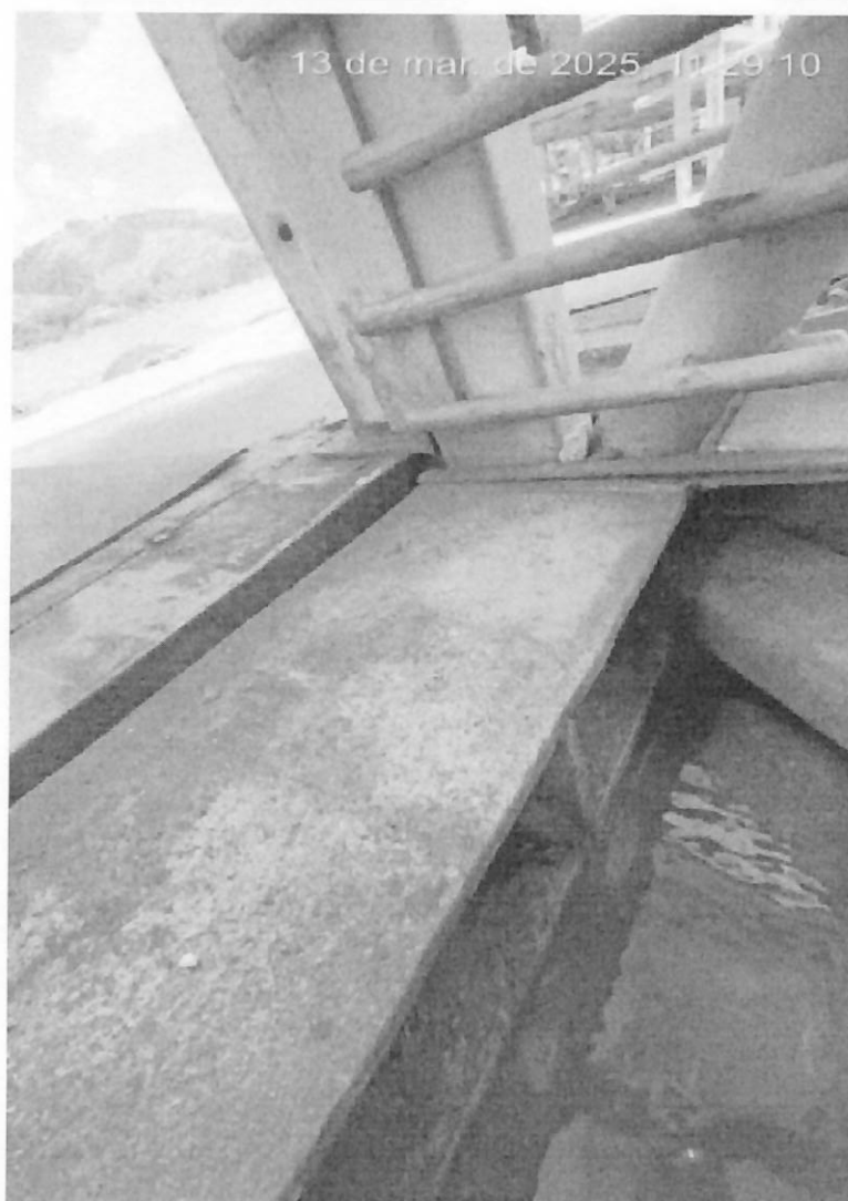
Figura 15 – Encontrado diferença de desnível entre a travessa mestre e o flutuante indicando que a esfera perfurou o leito e subleito causando rigidez e patolando junto ao flutuante, o que ocasiona a quebra rápida de toda a estrutura da passarela.
